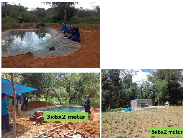
Gambar 19. Pembangunan bak tampung dan embung
