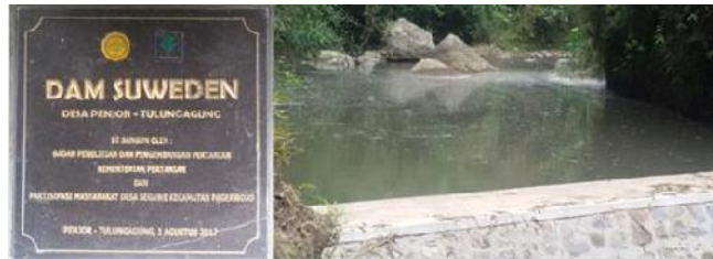
Gambar 7. Dam Parit Sungai Klantur di Kecamatan Pagerwojo, Kabupaten Tulung Agung, dengan debit 200 l/detik mampu mengairi lahan kering dan tadah hujan seluas 180 ha
