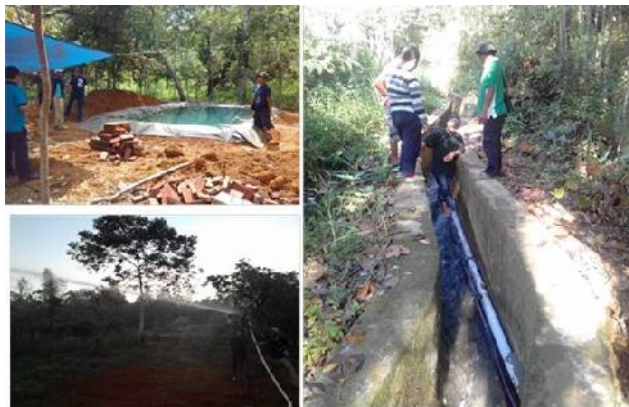
Gambar 8. Panen air melalui embung, sistem distribusi tertutup dg pipa, dan Big gun sprinkler yang diaplikasikan untuk mendukung budidaya palawija dan pakan ternak di Desa Lampoko, Kecamatan Barebo, Kabupaten Bone
